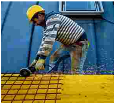
Am Bau sind viele Jobs in Gefahr. vowe
